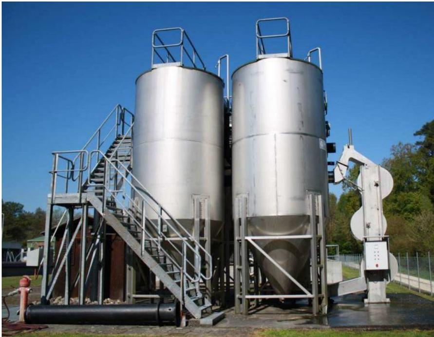
*Feinfilteranlage Kläranlage Moos (bei Radolfzell a. Bodensee) mit Wasserkraftmaschine im Ablauf*
